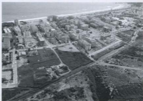
Vista aèria del recorregut principal de la Sèquia Major, on pot observar-se la pressió urbanística sobre l'espai natural
