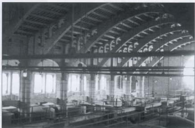
Vista de la sala gran del celler. El projecte comprendria l'eliminació de la majoria de les tines per donar lloc a una sala polivalent.
