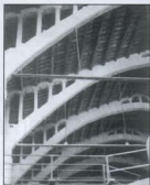
Vista dels arcs que aguanten la coberta de la nau central
