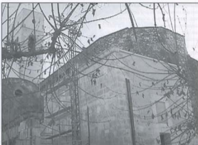
Les obres de restauració de la torre de l'Ardiaca han suposat l'enderrocament de les antigues peixateries
